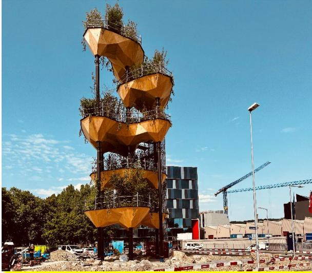
«Semiramis», die hängenden Gärten von Zug, ragen am Eingang zum neuen Tech Cluster Zug über 22 Meter in die Höhe. Sie bieten Lebensraum für einheimische Pflanzen und Kleintiere und bringen so die natürliche Vielfalt in das neue Quartier. Das Bauwerk besteht aus fünf überdimensional grossen Pflanzentöpfen aus Holz, welche auf schlanken Stahlstützen stehen.
