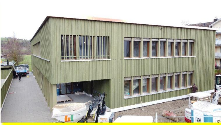
Für die Schulergänzende Betreuung im Schulhaus Sennweid haben wir die Fassade erstellt. Die gedämmten Fassadenelemente haben wir im Werk vorgefertigt und auf der Baustelle versetzt. Durch eine überlegte Planung der Fassadendetails konnte die Fichtenfassade effizient erstellt werden.
